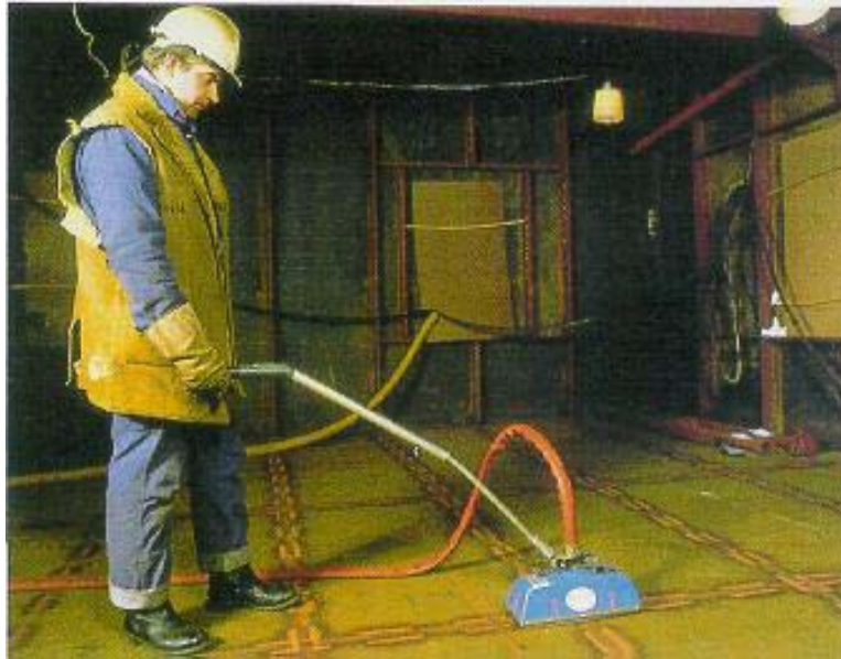
Fig. 6.9 Varmeretning af stålkonstruktion [41].
