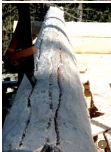
4 Træhytten bygges i lag på lag af træstammer. 5 Træstammerne blev tilpasset hinanden ved hjælp af en screiber, der kan overføre overfladekonturerne fra én stamme til en anden. 6 Det grove arbejde udføres med motorsav og finslibning med økse. 7 Thomas Olsens vigtigste hjælper var en jernhest - et lille bæltekøretøj, der kan forcere vanskeligt terræn med tungt læs. 8 Hytten står færdig.
