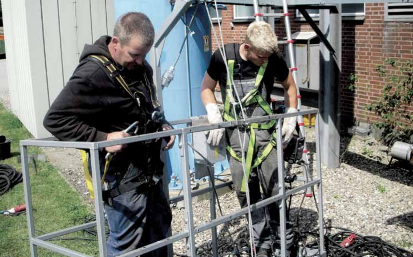
Kim Sørensen (t.v.) og Casper Nielsen på vej op i den ene af Svendborg Fjernvarmecentralers to skorstene.
