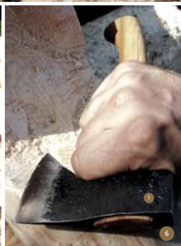
4 Træhytten bygges i lag på lag af træstammer. 5 Træstammerne blev tilpasset hinanden ved hjælp af en screiber, der kan overføre overfladekonturerne fra én stamme til en anden. 6 Det grove arbejde udføres med motorsav og finslibning med økse. 7 Thomas Olsens vigtigste hjælper var en jernhest - et lille bæltekøretøj, der kan forcere vanskeligt terræn med tungt læs. 8 Hytten står færdig.
