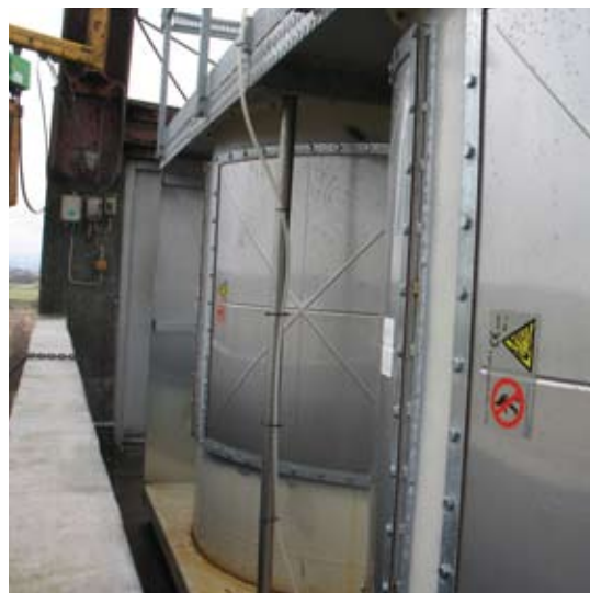
Eksplodingsaflastninger udendørs på toppen af nye siloer.
