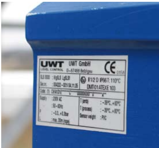
Ex-mærket niveaumåler til silo. Niveaumåleren er godkendt til at operere i zone 20 (materialkategori 1D).
