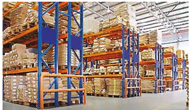
Figur 3 Risikoen er reduceret ved, at reolerne er sikret fysisk mod påkørsel.
