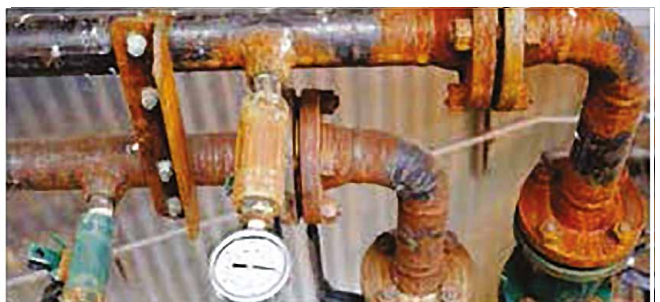
Figur 18 Inddrages det personale, der vedligeholder anlægget, kan der fremkomme værdifulde oplysninger om eventuel korrosion og begroninger eller belægninger omkring følere.
